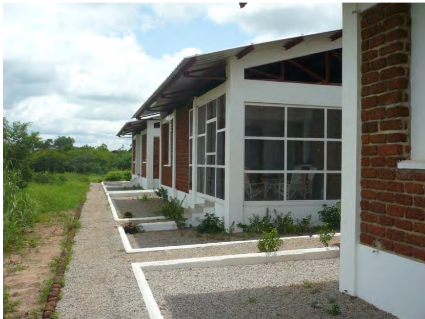
Unterkünfte auf dem Gelände der Dreyer-Stiftung in Dano
